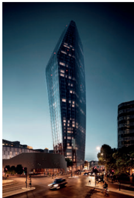
St George公司在伦敦开发的One Blackfriars住宅
