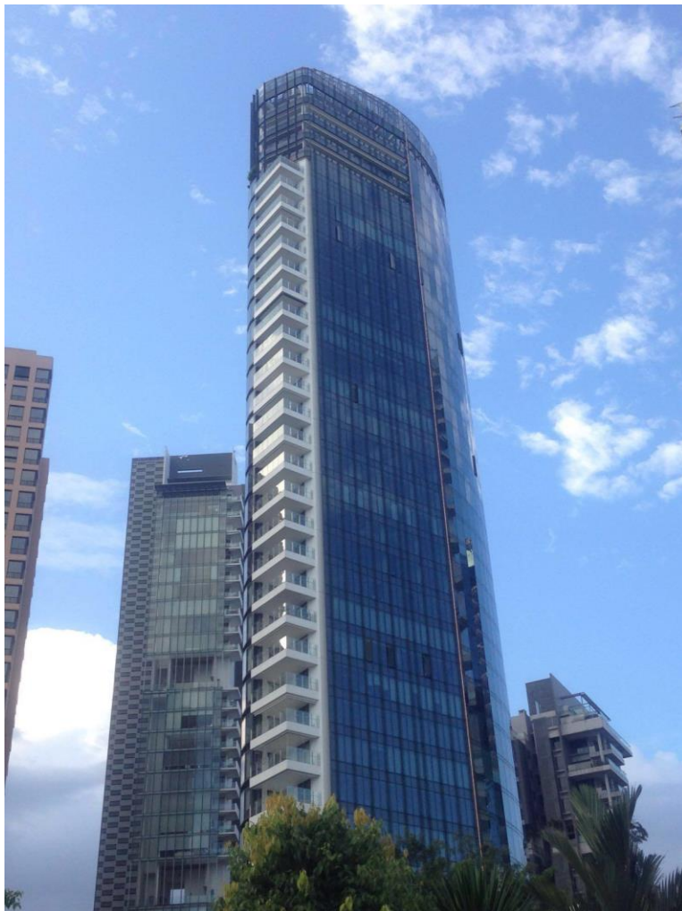
Boulevard Vue, D10
