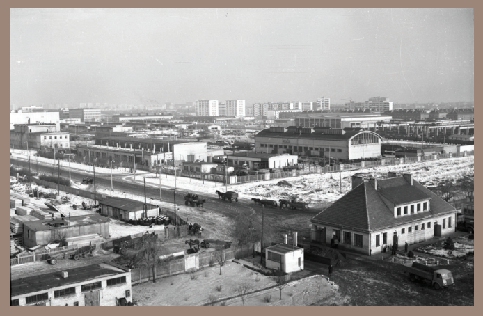
Widok ogólny Służewca Przemysłowego z góry. Widoczne zabudowania magazynowe i fabryczne, tzw. Południowa Dzielnicą Przemysłowo-Składową (PDPS)
