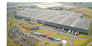
Plateforme logistique , Saint-Sauveur (80)
