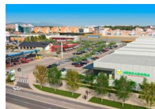
RETAIL PARK TERRASSA PLAÇA Terrassa, Barcelona SBA: 30.535 m 2 Octubre 2017
