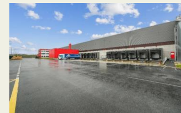
Entrepôt Lapeyre, Mer (41)
