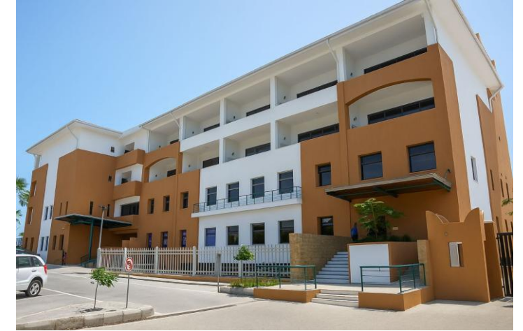
Cordura Complex, Dar es Salaam
